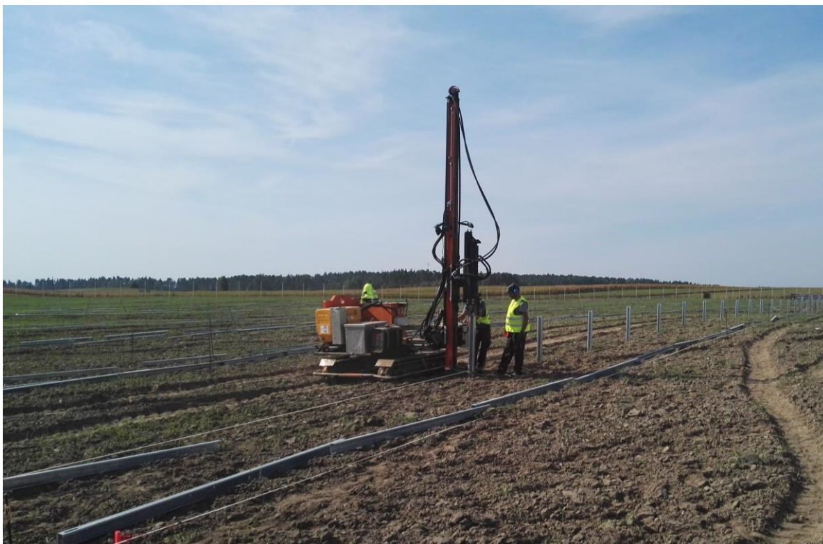
Rysunek 14 Katar do wbijania profili nośnych
